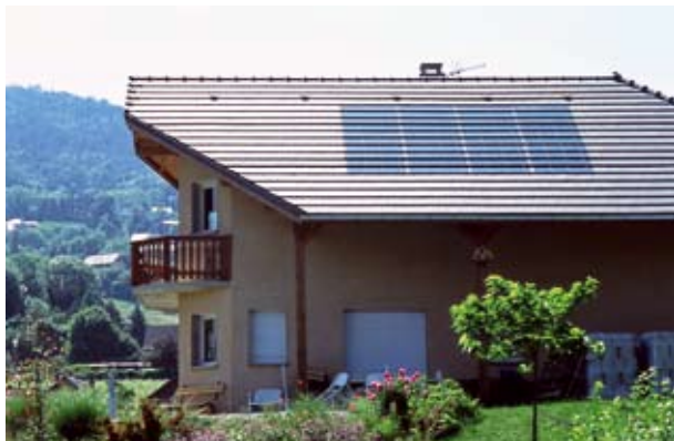
Les modules photovoltaïques peuvent être installés sur un toit, un auvent, une façade... et intégrés au bâti.
