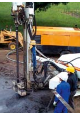
Pose d'une sonde géothermique
